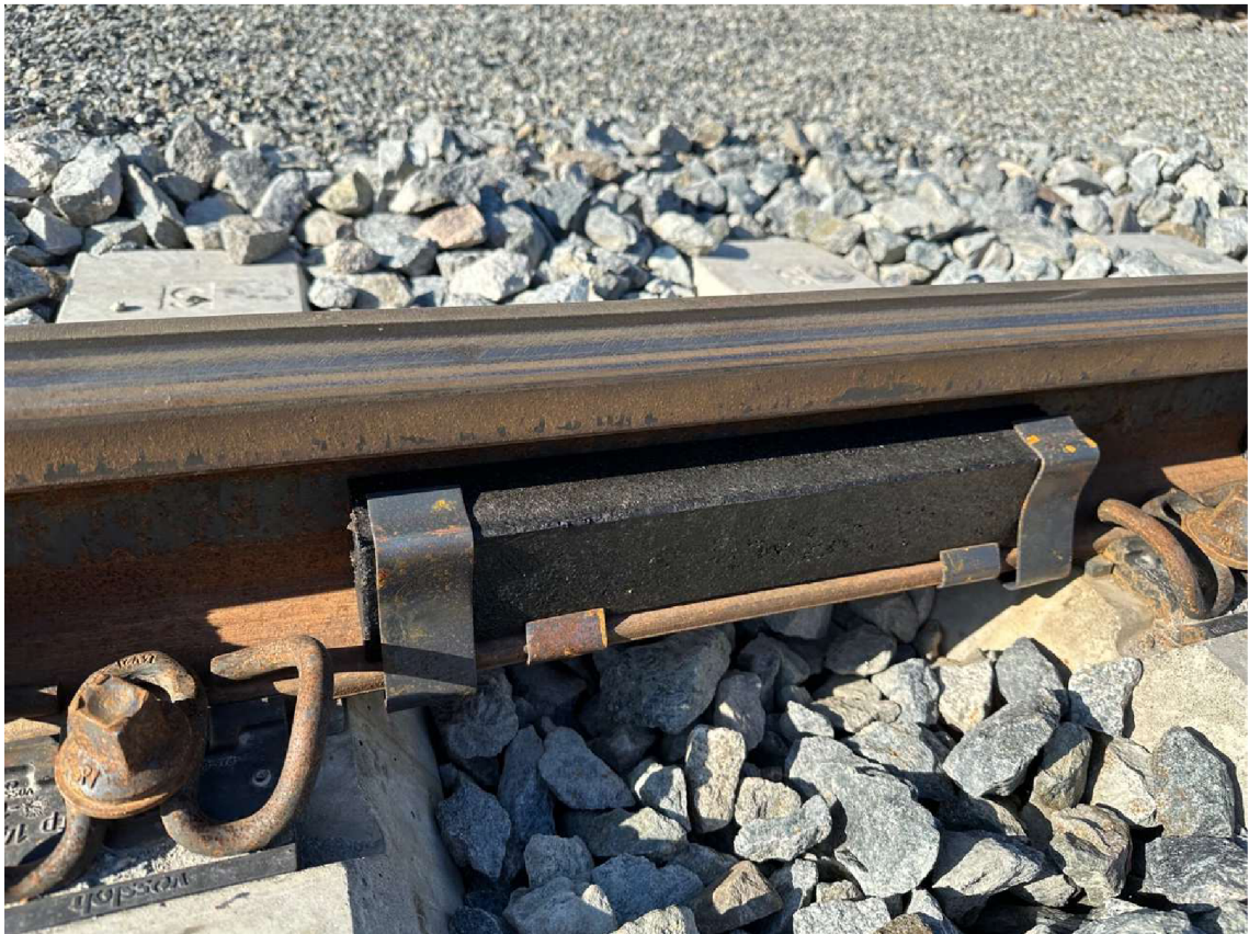
Obrázek 3.2 Bokovnice připevněná ke kolejnici
