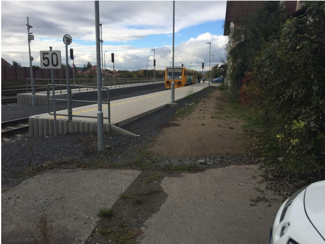
OBRÁZEK 14 VSTUP NA NÁSTUPIŠTĚ Z ODSTAVNÉ PLOCHY "C" ZDROJ: AUTOR
