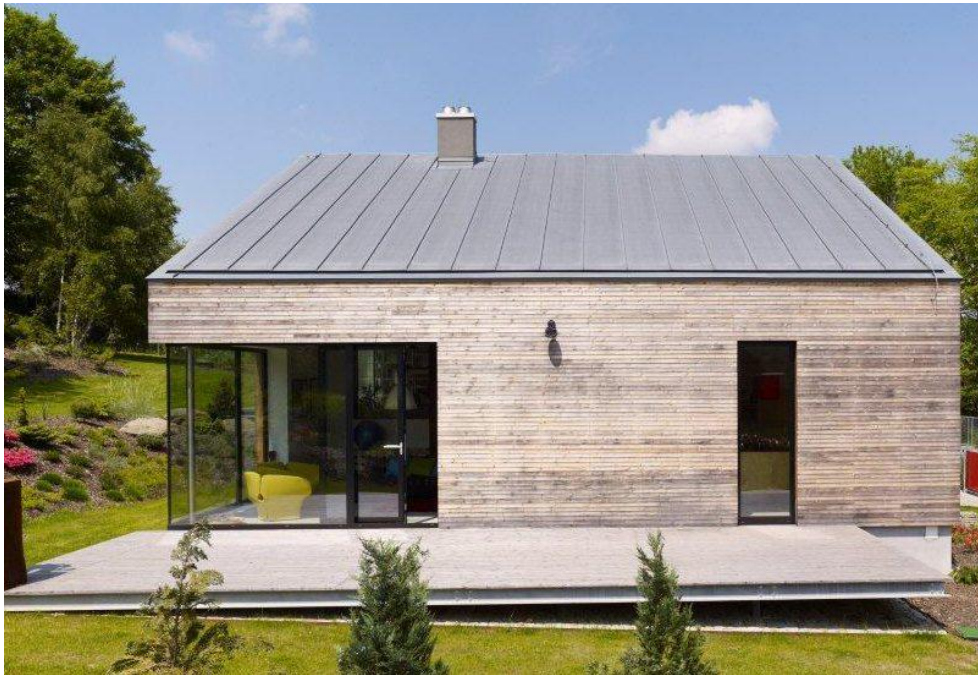
Obr. 3: Exteriérové obklady z materiálu ThermoWood bez provedení povrchové úpravy (PROKOM R&S s.r.o., 2013).
