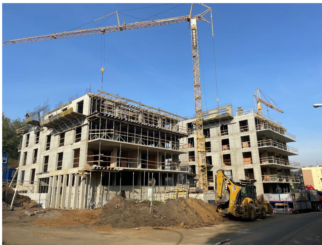
Obrázek 7 – Pohled na objekty A (vlevo) a B (vpravo) z ulice Horní [zdroj vlastní]
