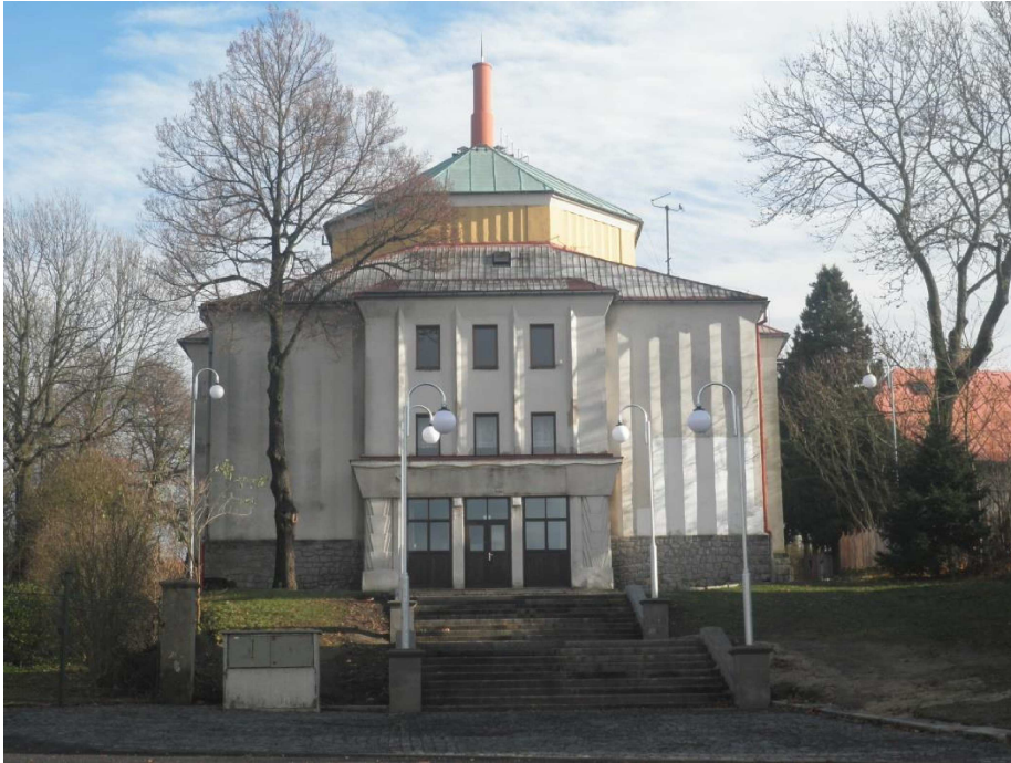
Příloha 14 Budova bývalého kina v Kamenickém Šenově
