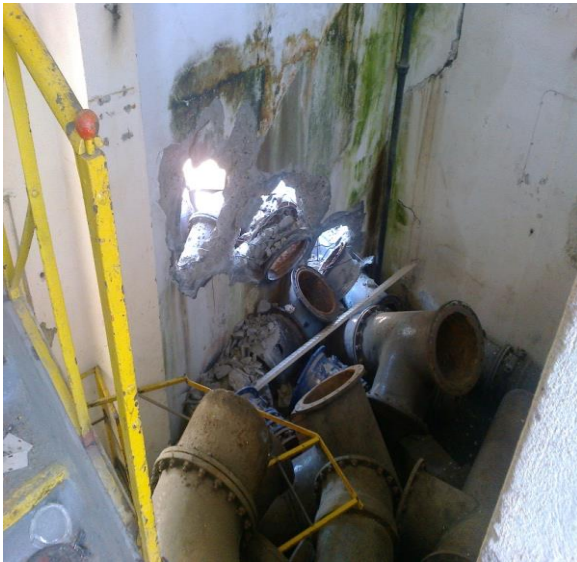
Obrázek 12.1 - Vybourání prostupů mezi VDJ a AK
