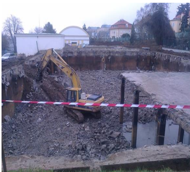
Obrázek 11.3 - Bourací práce železobetonového stropu
