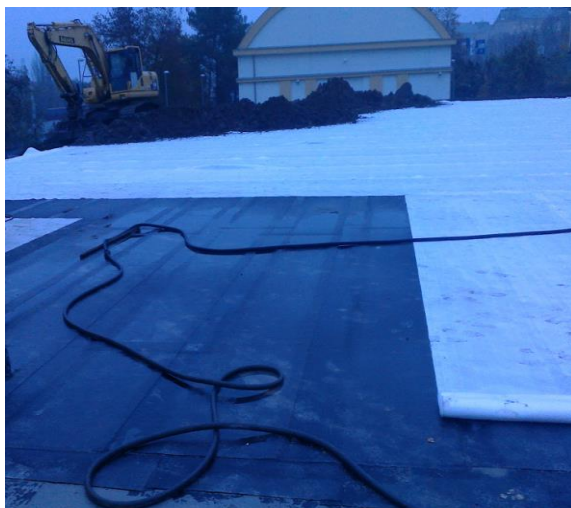
Obrázek 11.12 - Pokládka geotextilie a zásyp VDJ
