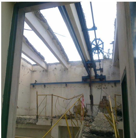
Obrázek 12.2 - Vybourání stropu AK
