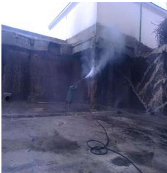
Obrázek 11.4 - Vysokotlaké čištění vodním paprskem nosného sloupu armatraturní komory
