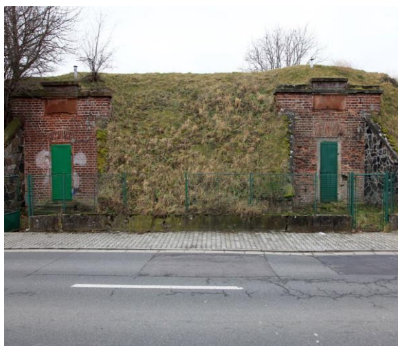
Obrázek 9.5 – Zemní vodojem s dvěma armaturními komorami
