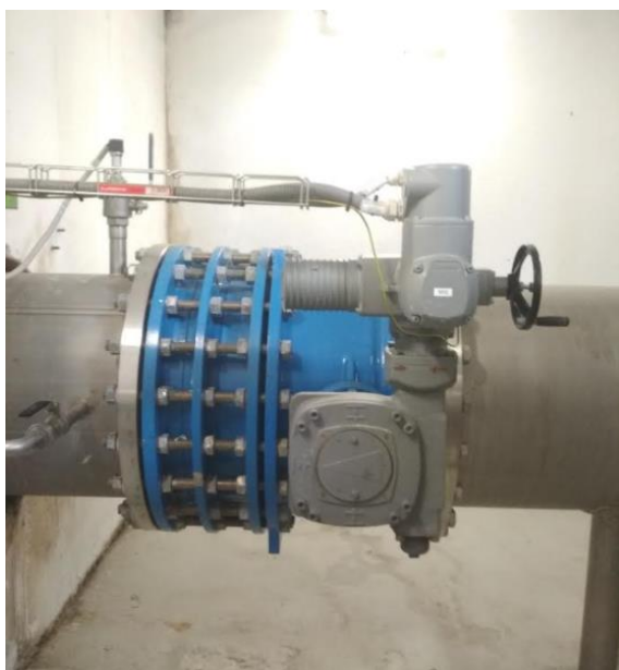
Obrázek 12.3 - Klapka DN 700 s elektropohonem
