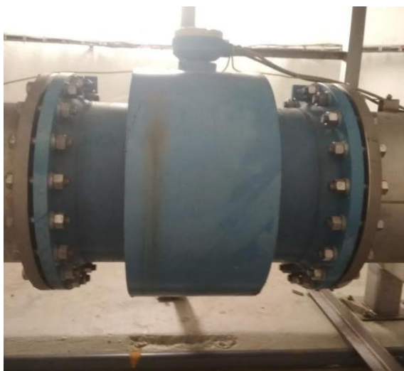
Obrázek 12.7 - Indukční průtokoměr oddělená verze DN 700 Podolí-Bruska
