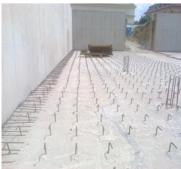
Obrázek 11.8 - Betonáž dna vodojemu včetně armovací ocele
