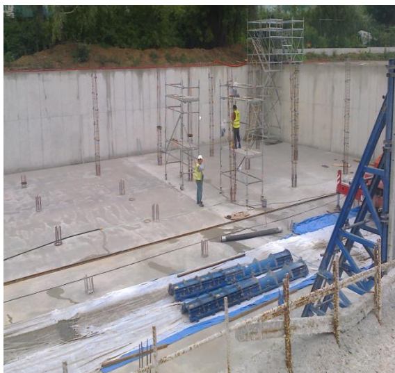
Obrázek 11.9 - Výroba sloupů VDJ
