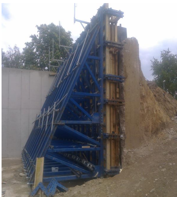
Obrázek 11.7 – Ukázka bednění východní stěna
