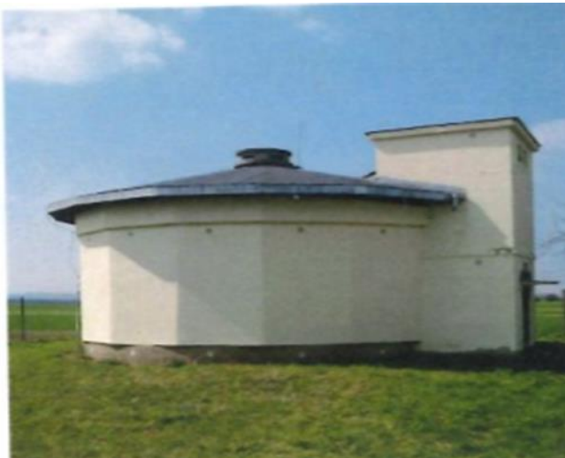
Obrázek 9.7 - Vodojem z nezasypanou akumulční nádrží na povrchu terénu
