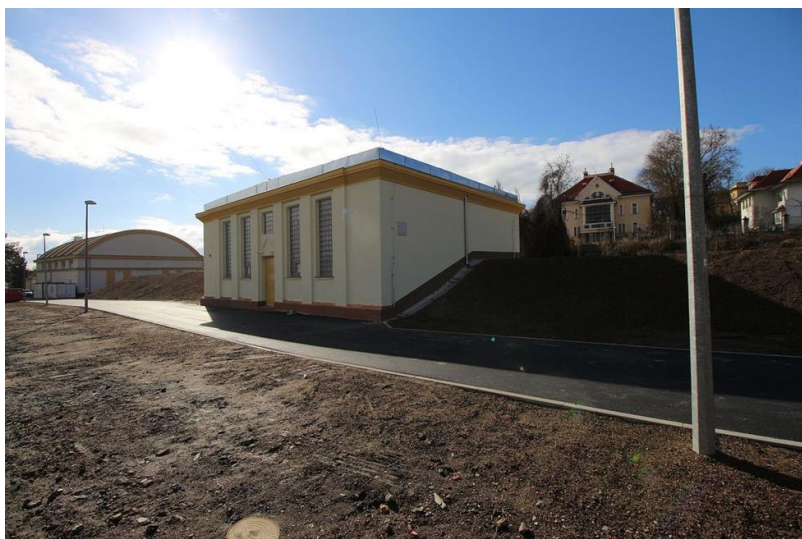
Obrázek 11.1 - Pohled na VDJ po rekonstrukci
