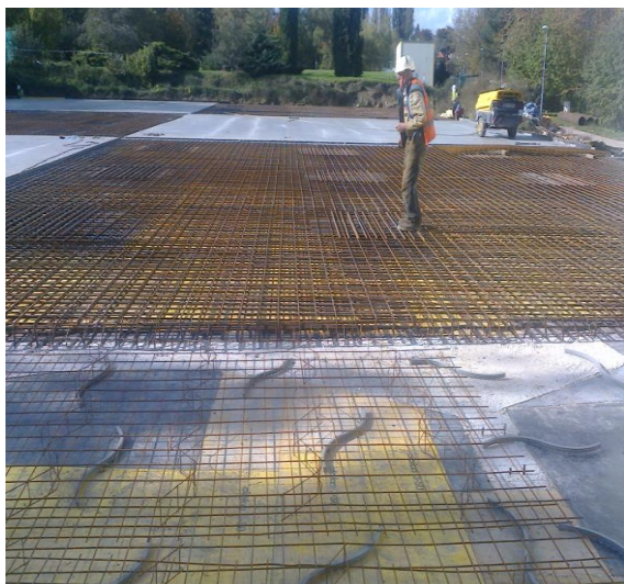
Obrázek 11.10 - Rozdělení ploch a příprava pro betonáž
