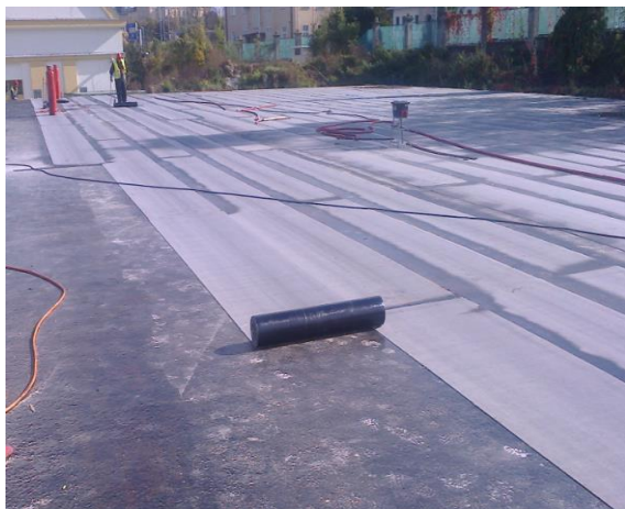
Obrázek 11.11 - Pokládka izolace
