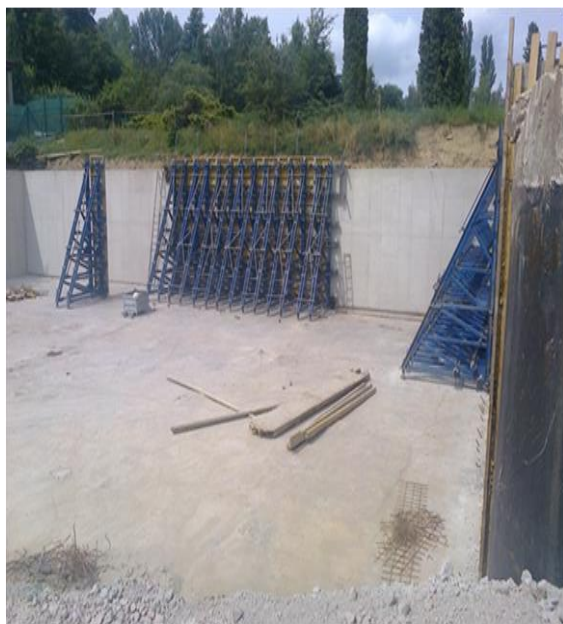
Obrázek 11.6 - Bednění pro betonáž západní stěny vodojemu
