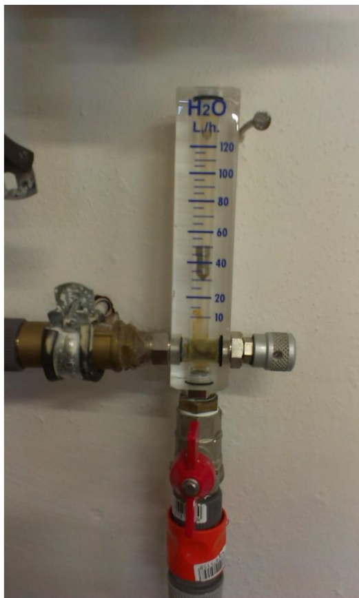
Obr. 7. 12 Průtokoměr [autor]
