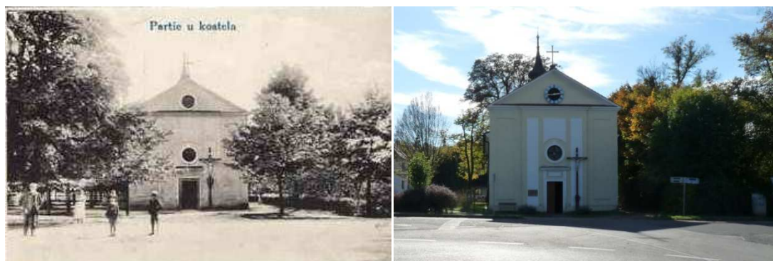
Obr. č. 15: Kostel Povýšení sv. Kříže z roku 1937 a fotografie zachycující kostel v roce 2014. Zdroj dat: Antikvariát Arco a foto autor (2014).
