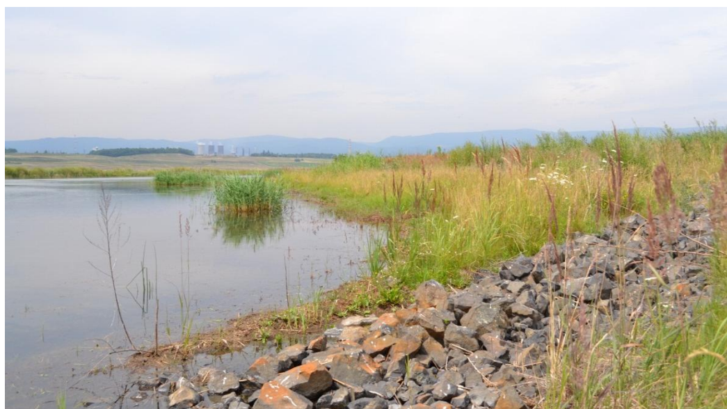
Obr. č. 6 - Protierozní kamenné záhozy na východním okraji jezera Most (foto vlastní)
