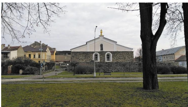
Obr. č. 8: Synagoga v Lipníku nad Bečvou
