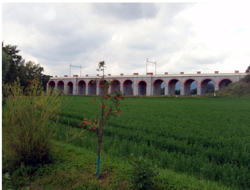
Obr. č. 13: Jezernické viadukty
