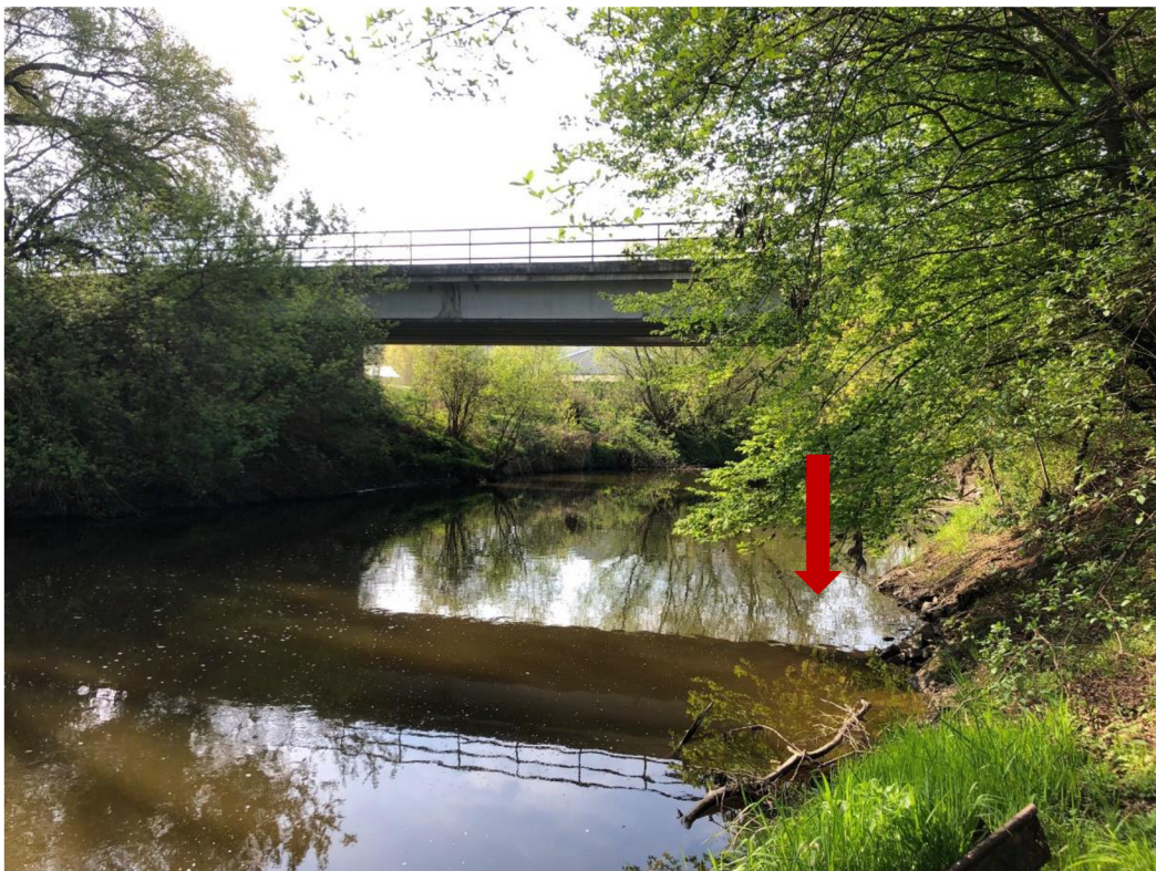
Příloha 12: Lokalita č. 4 - Ivančice (železniční most)
