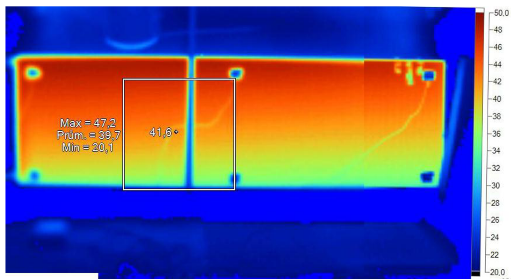
Obr. : Snímek pořízený termokamerou Fluke thermal imager TI 45 při 3. měření bez zakrytí krytem otopného tělesa (barevná škála 20°C-50°C).
