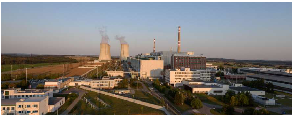
Obrázek č. 15: Bližší pohled na jadernou elektrárnu Dukovany
