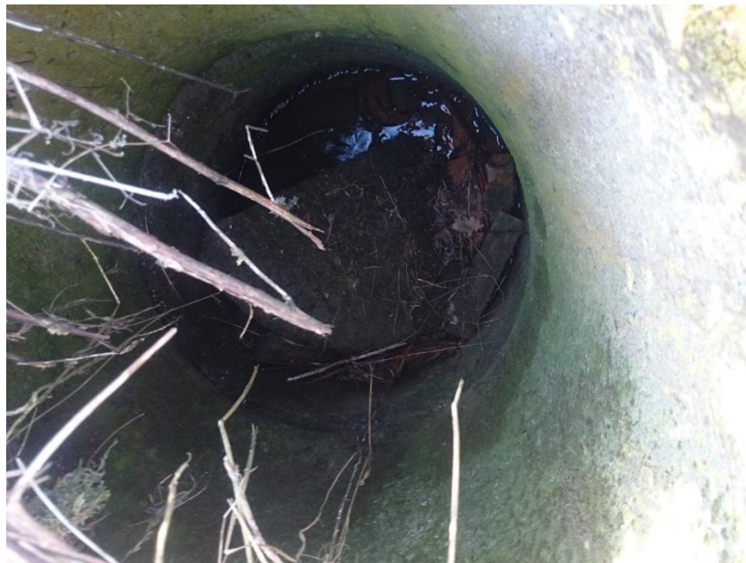
Obr. 16: Kontrolní šachtice č. 1, [Fotodokumentace: zpracování vlastní]
