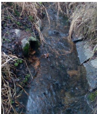
Obr. 14: Výust' „0“ svedená do Kamenného potoka, [Fotodokumentace: zpracování vlastní]
