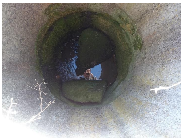
Obr. 18: Kontrolní šachtice č. 3, [Fotodokumentace: zpracování vlastní]
