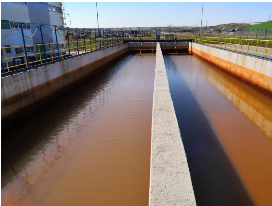
Obrázek 6: Vyrovnávací nádrže VN1 a VN2 pro Mn vody (vlastní foto)
