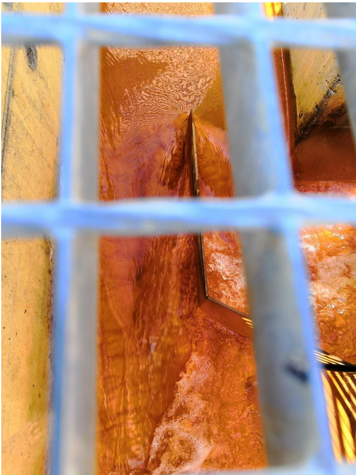
Obrázek 8: Nátokový kanál, který rozděljuje vodu do UN1 a UN2 – detail na železitý povlak (vlastní foto)
