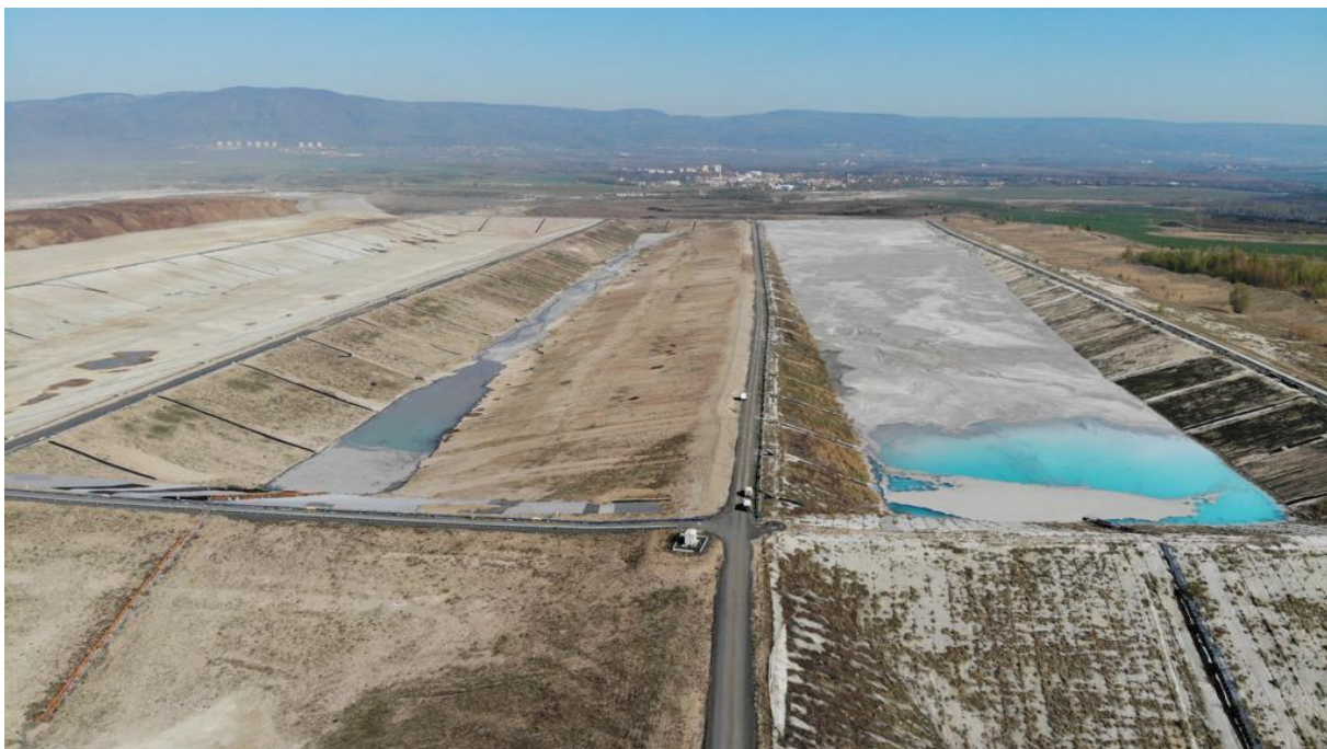
Obrázek 5: Usazovací nádrže UN1 a UN2 pro Mn vody (vlastní foto)
