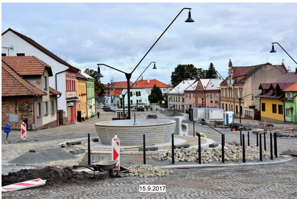
11 - Rekonstrukce náměstí ve městě Nasavrky, na fotografii je zachycena modernizace z horní části náměstí, včetně místa před autorem vybranými st. parcelami č. 40 a 41
