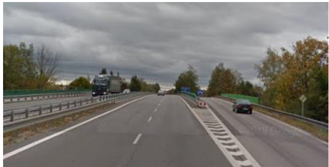
Obr. č. 19: I/34 do Třeboně ve směru od JH (zdroj: https://google.com/maps/ [2019])
