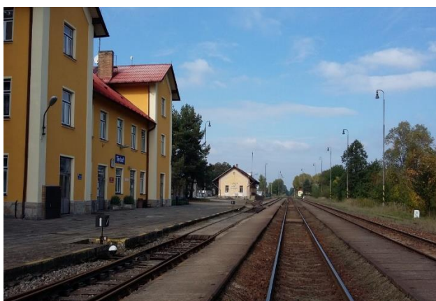
Obr. č. 10: Stanice Třeboň
