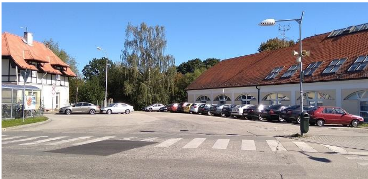
Obr. č. 54: Plocha pro odstavení vozidel včetně vjezdu a výjezdu z AN (zdroj: autor [2020])
