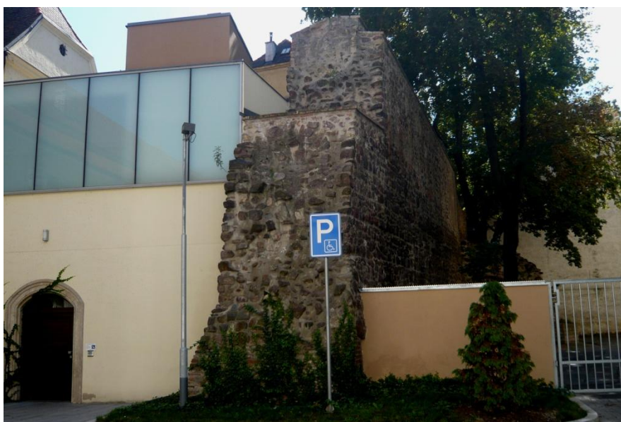
Obr. 2.1 Fragment původního městského opevnění za Střední umělecko-průmyslovou školou na ulici Husově [foto Z. Nováková]
