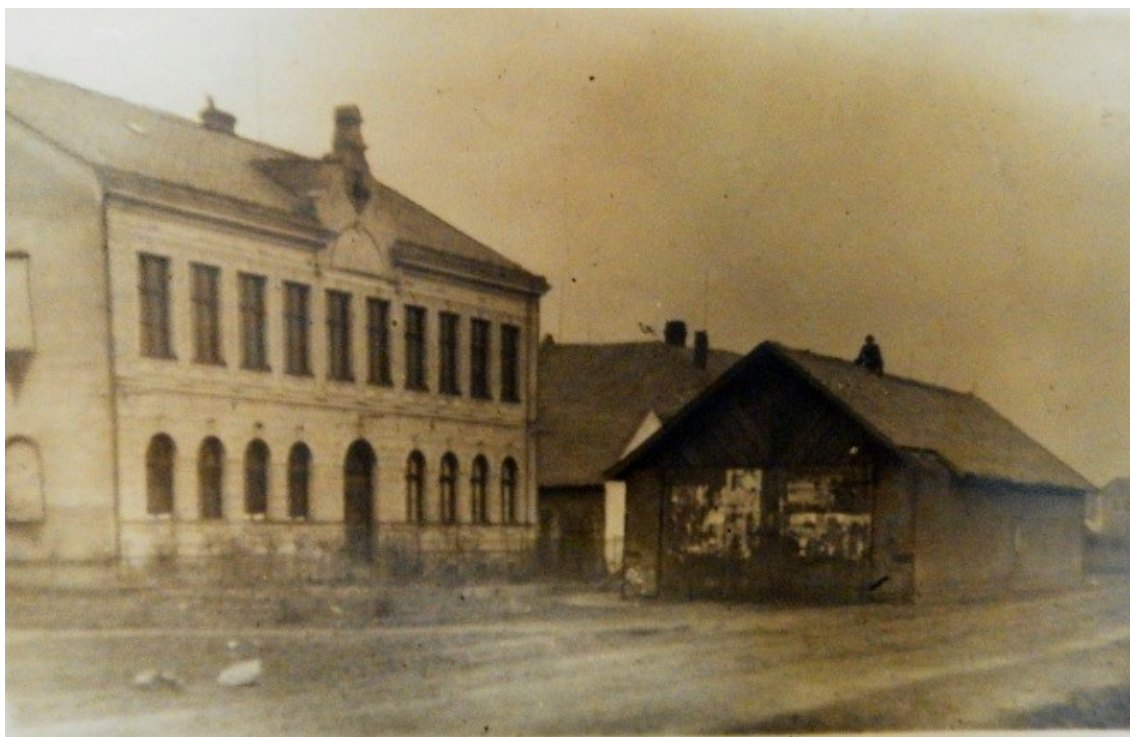
Budova nové školy z roku 1904 a obecní kůlna, která byla zbourána 17. 3. 1930 (zdroj: SOkA Olomouc).
