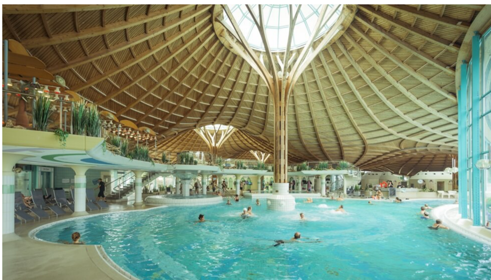
Obrázek 14 Prostorová dřevěná konstrukce (Theremencheck, 2010)
