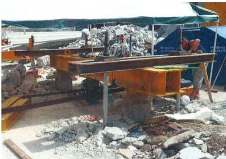
Obrázek 5.2 Tlaková zkouška mikropiloty, dostupné z: Technischer Bericht Pfahlprüfung, fa Keller
