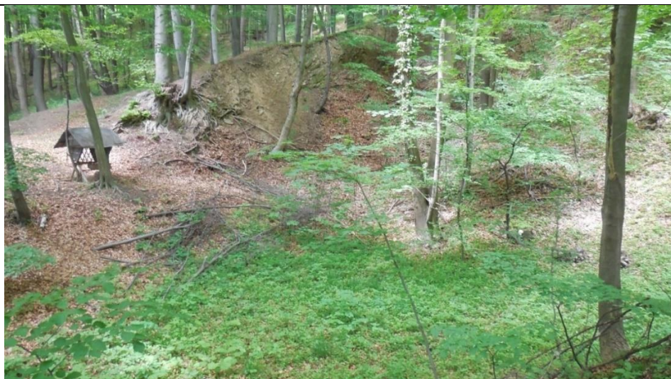
Obr. č. 29 Vrchní pohled na VKP Kuběnovo lomnisko
