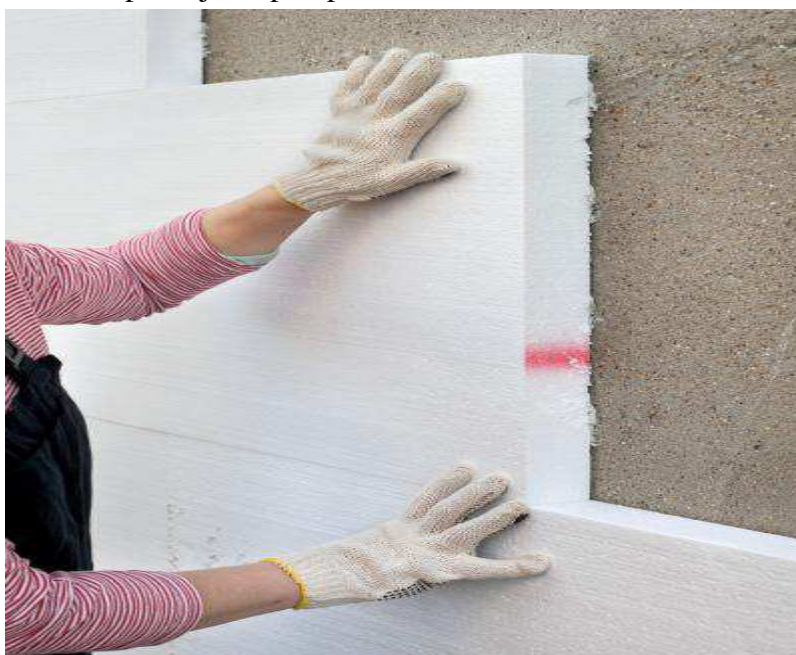
Obrázek. č. 17 - Vnější zateplování fasády pěnovým polystyrénem [39]
