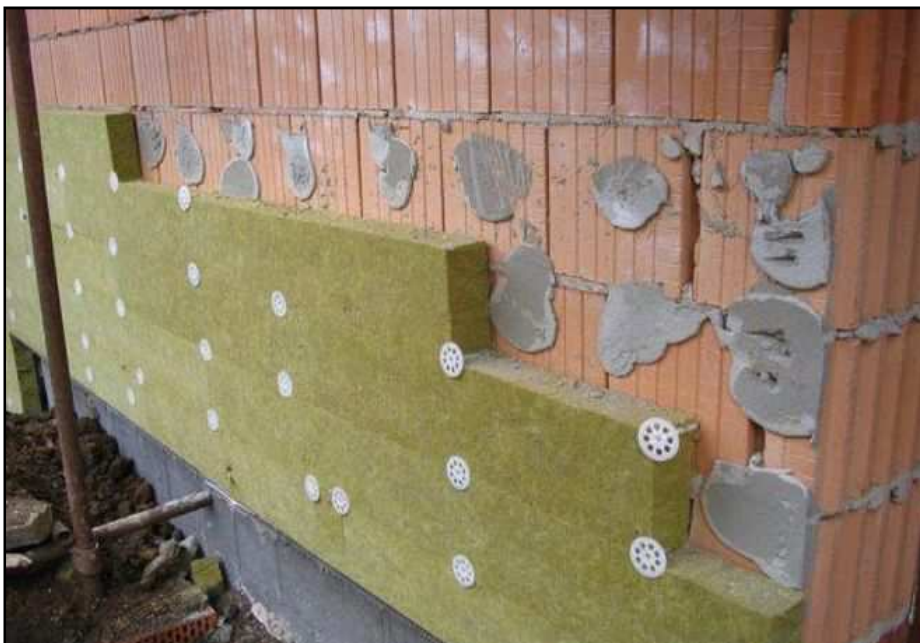
Obrázek. č. 20 – Lepení izolace na buchtly [41]
