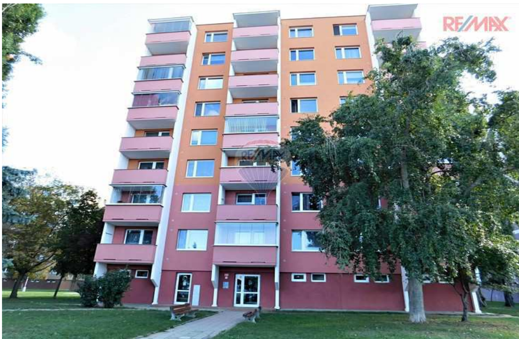
Obr. č. 12 – Sídliště Dukelská [40]
