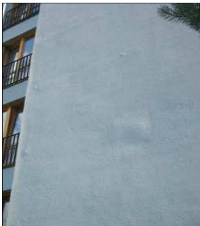
Obrázek. č. 21 – Boule na provedeném zateplení [41]
