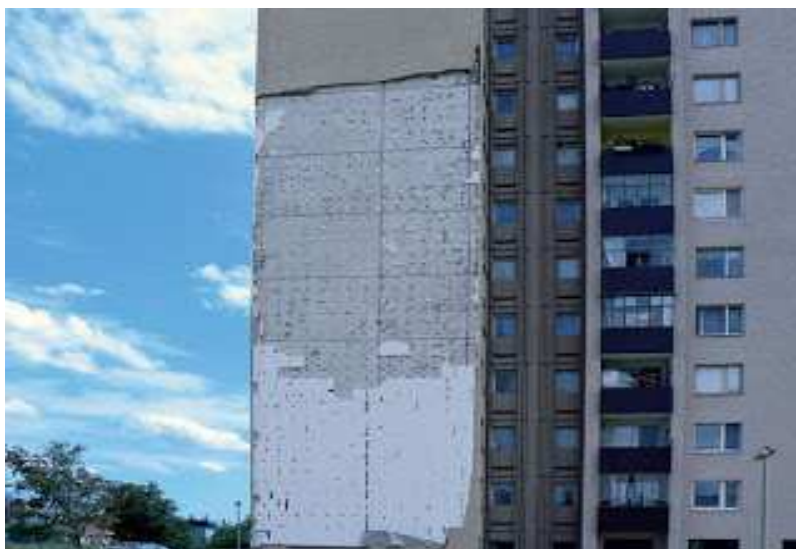
Obrázek. č. 19 – Nekvalitně provedené zateplení [41]
