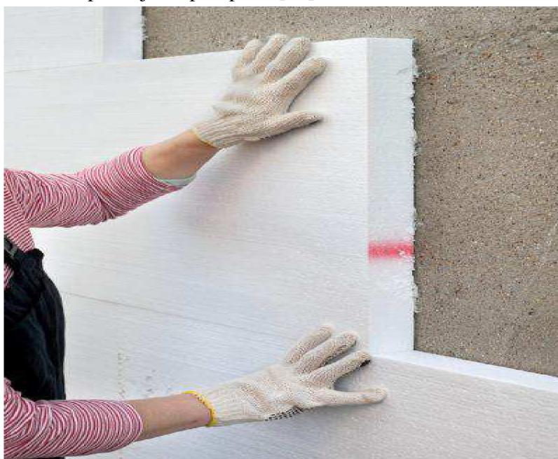
Obrázek. č. 17 - Vnější zateplování fasády pěnovým polystyrénem [39]
