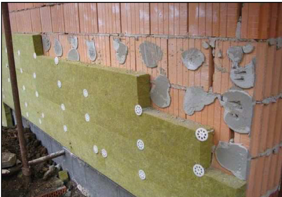
Obrázek. č. 20 – Lepení izolace na buchtly [41]
