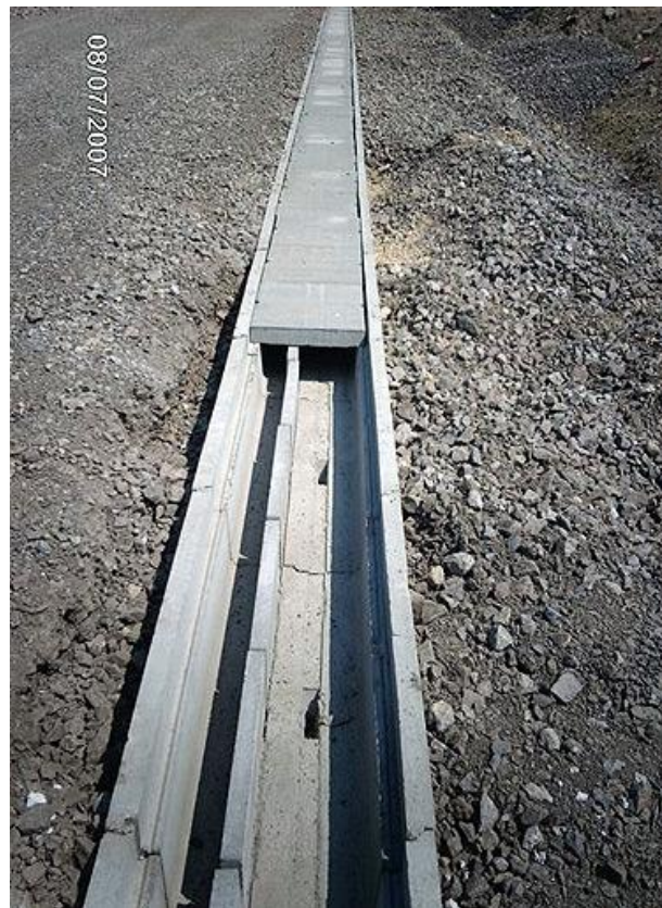
Obr. 2.7: Betónový káblový žľab
