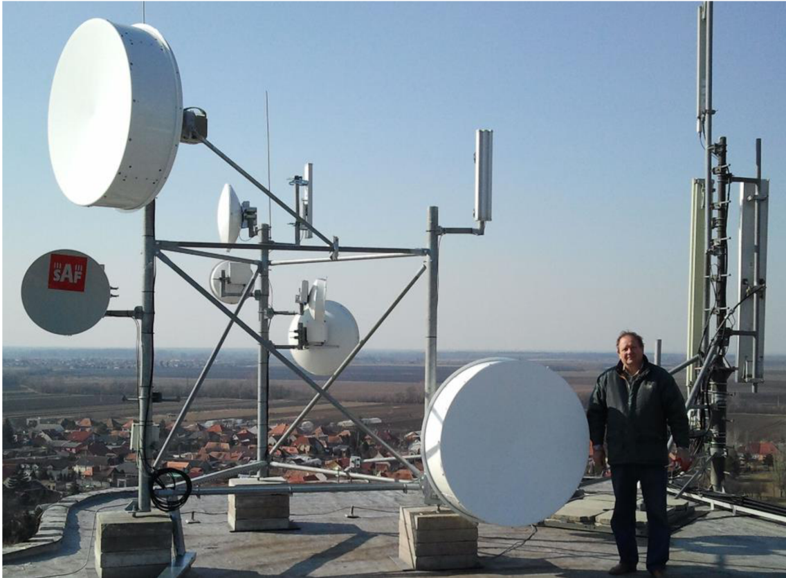
Obr. 3.6: Inštalácia smerových antén Andrew priemeru 120cm pre pásmo 13 GHz.
