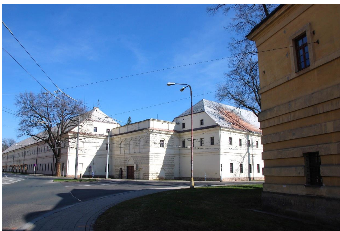
Obrázek 3 Fotografie nároží pěchotních kasáren. V pravé části snímku jezdecká kasárna.
