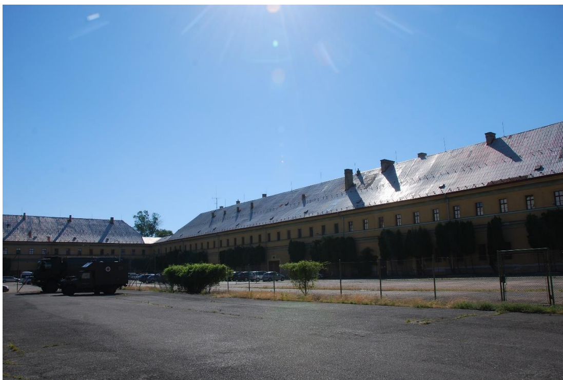
Obrázek 35 Množství různorodých komínových těles na střechách východní a jižní budovy, 24. 6. 2022
