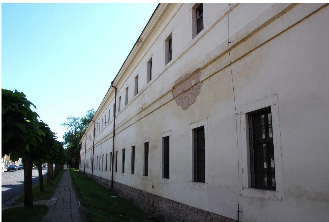
Obrázek 13 Současný stav fasády, z pohledu ul. Komenského.
