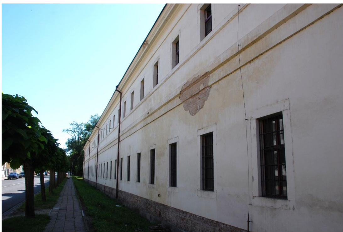
Obrázek 13 Současný stav fasády, z pohledu ul. Komenského.
