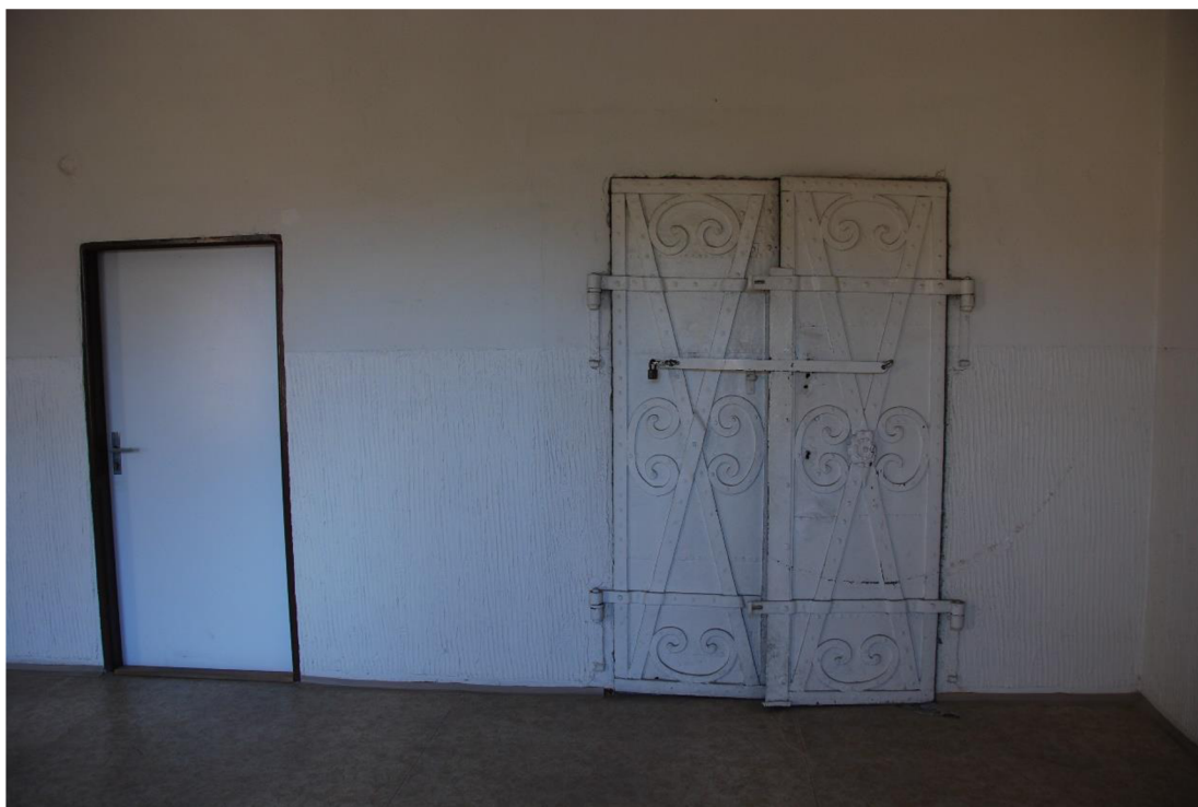
Obrázek 34 Vstup na půdu – jediné dochované historické dveře v objektu, 24. 6. 2022
