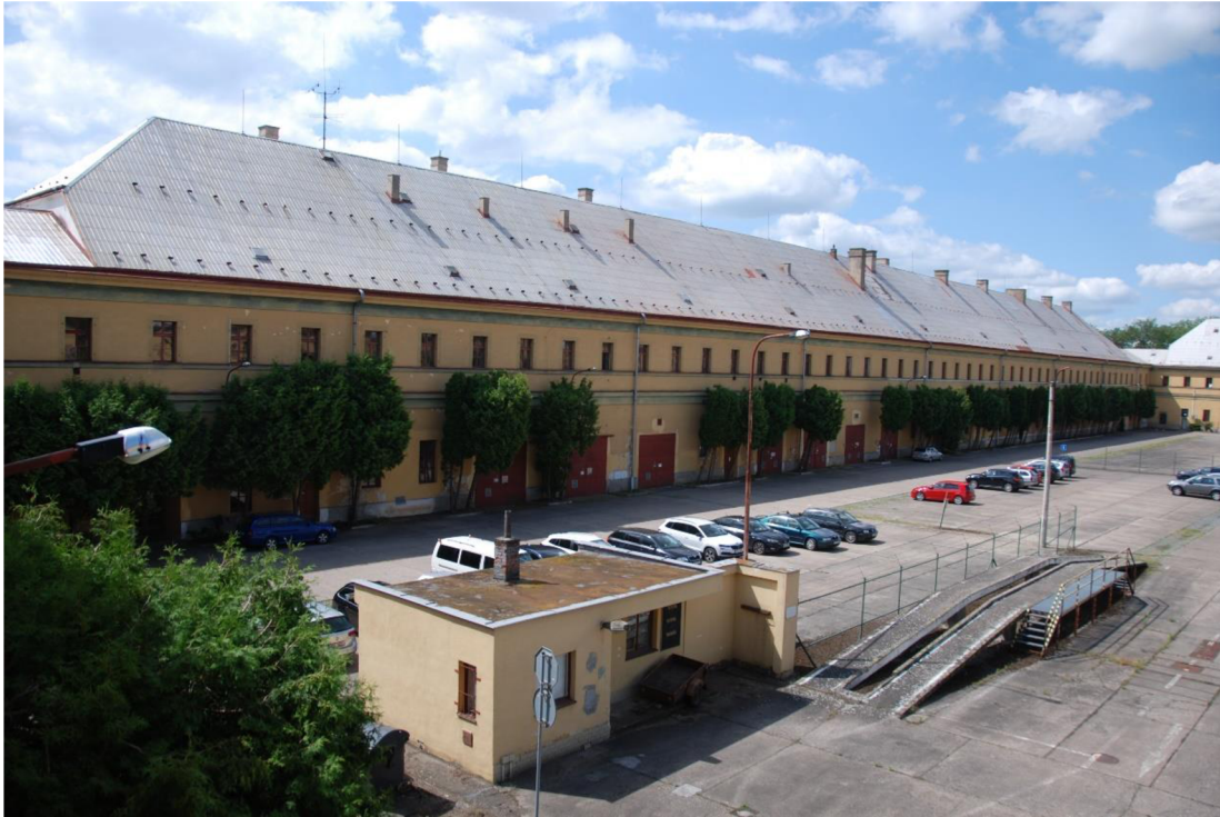
Obrázek 32 Prolémová vegetace v nádvoří kasáren. Pohled z patra budovy, 17. 6. 2022.
