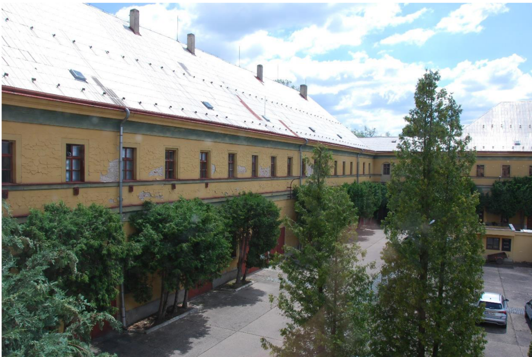
Obrázek 33 Prolémová vegetace v nádvoří kasáren. Pohled z patra budovy, 17. 6. 2022.
