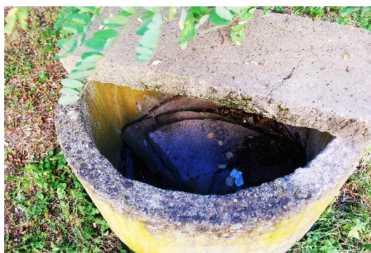
Obrázek 12 Současný stav studny
