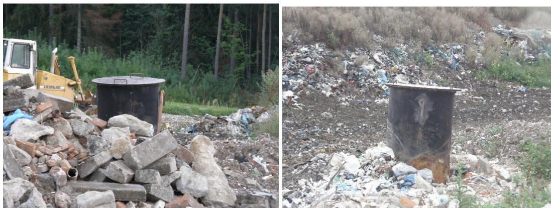
Obrázek 23: Plynové studny
