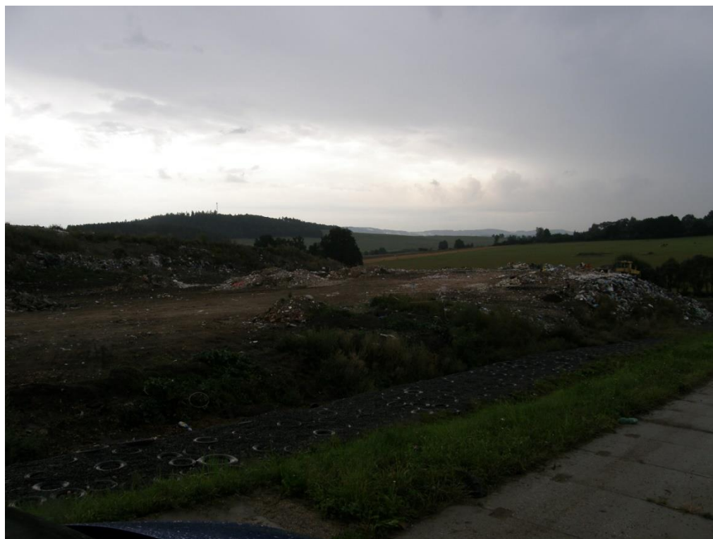
Obrázek 57: Těleso skládky s odvodňovacím příkopem a přilehlou komunikací
