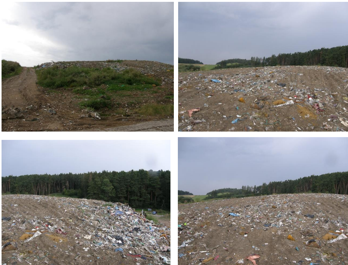
Obrázek 25: Překrytí skládky krycím materiálem
