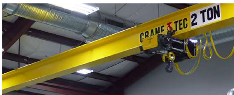
Obr. 6 Mostový jeřáb s plnostěnným nosníkem [22]
