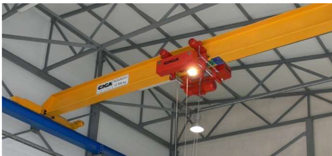
Obr. 3 Podpěrný mostový jeřáb jednonosíkový [18]
