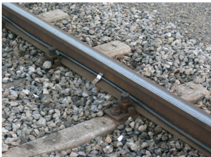
Obr. 1.3: Ukážka systému Euroloop. [1]
