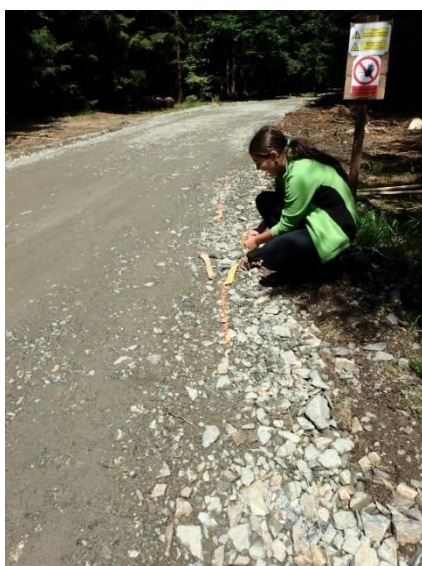
Obr. 12: Vytyčení výšky návozu
