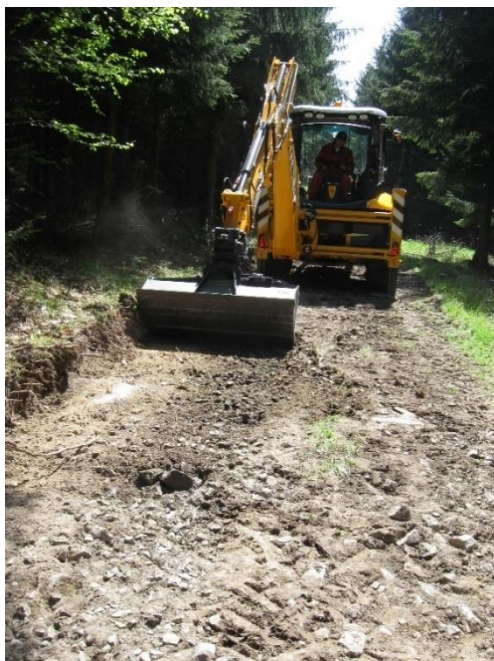
Obr. 10: Úprava pláně
