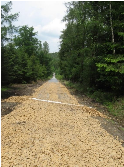
Obr. 20: Svodnice zabudovaná v kamenivu
