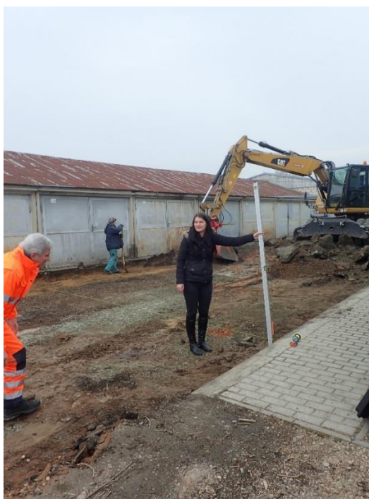
Obr. 41: Skrývka původního nestmeleného zpevnění
