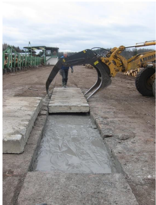
Obr. 27: Pokládání panelů
