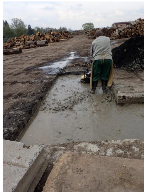
Obr. 25: Hutnění vrstvy
