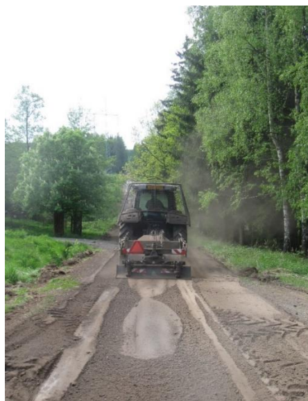
Obr. 17: Frézování krytu – pojezd středem
