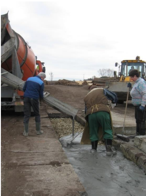
Obr. 24: Prolévání suspenzí
