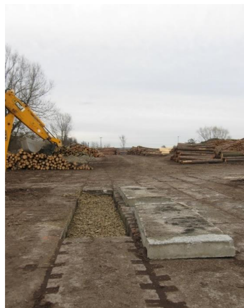
Obr. 23: Navezení a rozprostření kameniva
