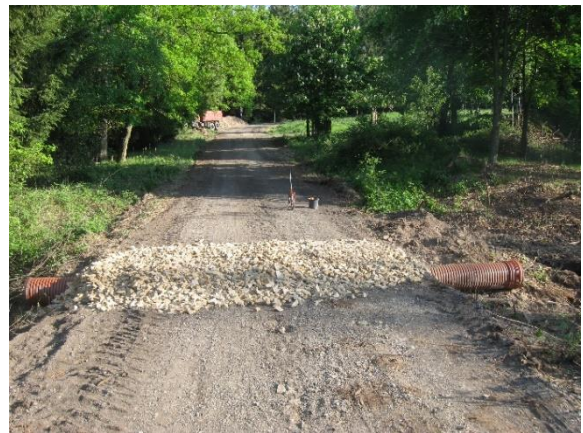
Obr. 19: Stavba propustku
