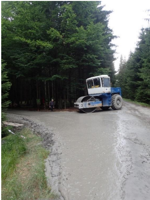
Obr. 14: Hutnění vrstvy
