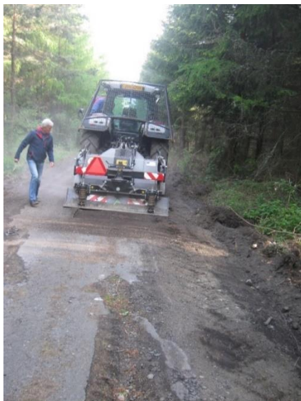
Obr. 16: Frézování krytu – pojezd pravou stopou
