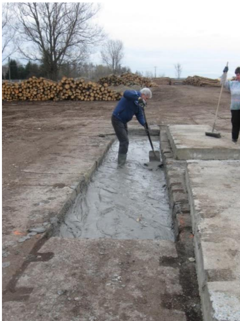
Obr. 26: Rozprostření suspenze
