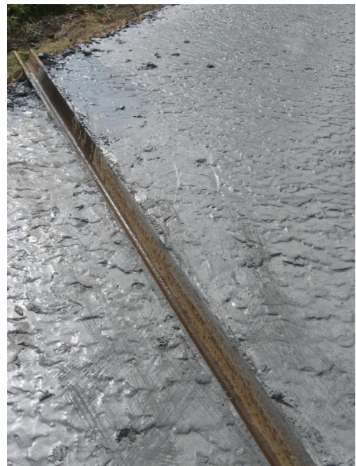
Obr. 21: Svodnice po prolití a vyčištění
