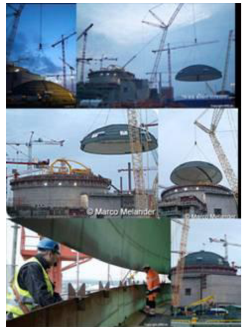
Obrázek 2.2: Stavba kontejnmentu.
