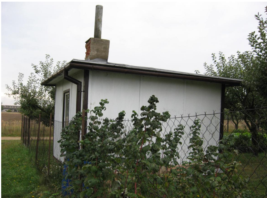
Zahrádkářská chata pochází z roku 1972 a nachází se v zahrádkářsko – rekreační osadě Třebenice – CHAAZ – r. Brodka (VY12.Z.19.). Foto – Válek.
