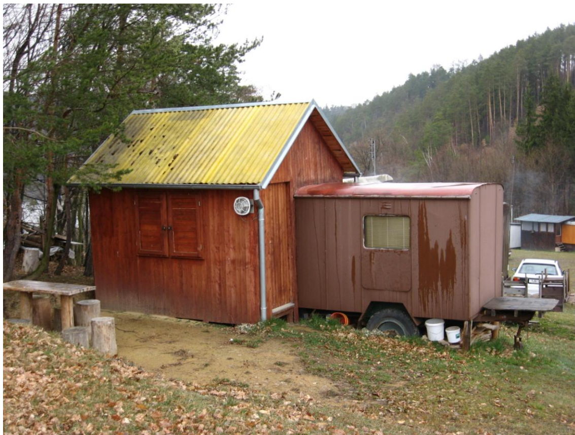
Foto 28. Architektonicky – specifická chata (CHAAS) subtyp dlouhodobě zaparkovaný přívěs .
