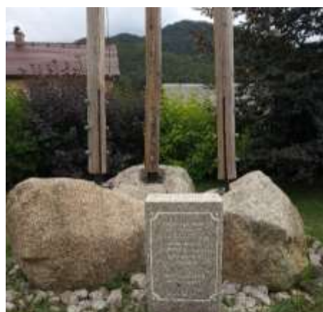
Obrázek 14 - Detailní pohled na ukotvení zvoničky do žulových balvanů a na pomník, zdroj: vlastní foto
