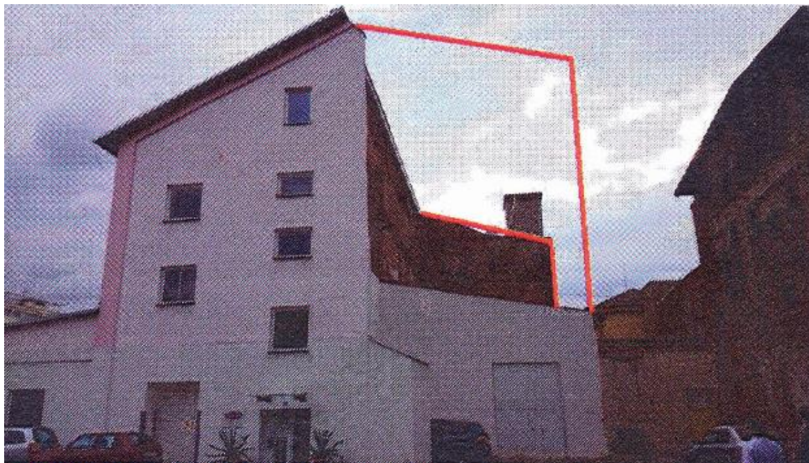
Obrázek 19: 1. část rekonstrukce (výroba, balení, skladování)
