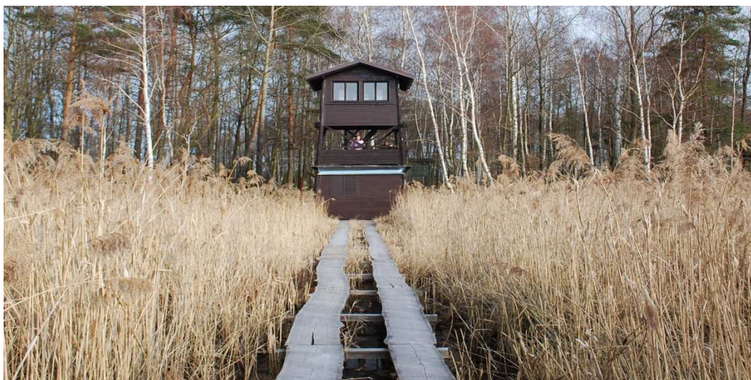
Obr. č. 6: Pozorovací věž
