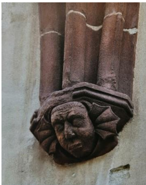
61. Sázava, bývalý benediktinský klášter, kostel sv. Prokopa – nedostavěné halové trojloží – konzola s maskaronem, třetí čtvrtina 14. století
