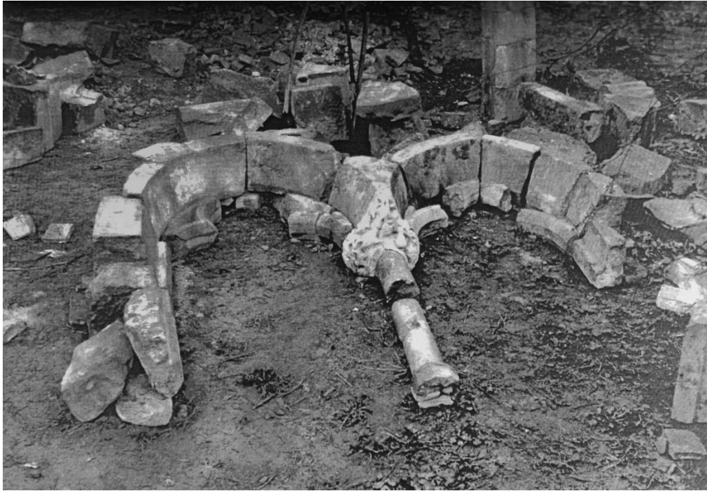
41. Brno-Komárov, kostel sv. Jiljí, archivní fotografie – pokus o rekonstrukci dvojitého okna z nalezených fragmentů při archeologickém výzkumu okolí kostela sv. Jiljí v Brně-Komárově
