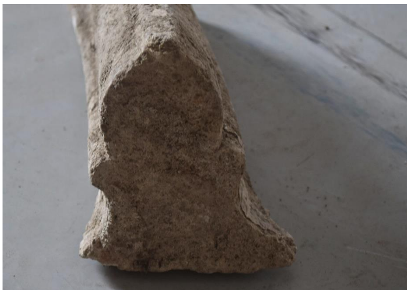
39. Vyškov, Depozitář Muzea města Brna, fragment klenebního žebra s hruškovým profilem, třetí čtvrtina 14. století (?)
