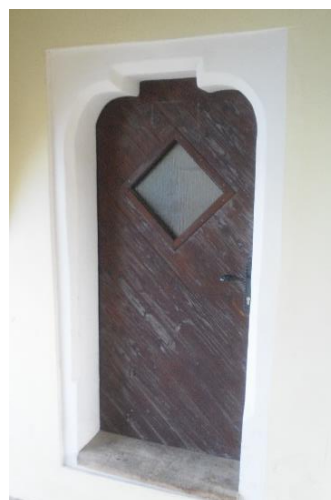
47. Znojmo, kaplanka – U Branky čp. 485/6, detail sedlového portálku, kolem 1440
