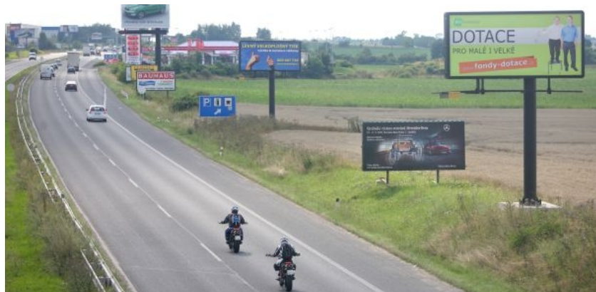
Obr. 15 Nehráněné nosné konstrukce reklam svodidlem Zdroj: Tyden.cz: Nebezpečné billboardy u silnic: odstranit jich půjde minimum [online]. [cit. 7.9. 2022]. Dostupné z: https://www.tyden.cz/rubriky/domaci/doprava/nebezpecne-billboardy-u-silnic-odstranit-jich-pujde-minimum_201722.html?showTab=nejctenejsi-24
