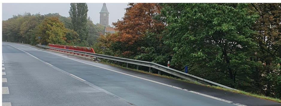
Obr. č. 9 Ocelová svodidla se zábradelní konstrukcí Zdroj: vlastní
