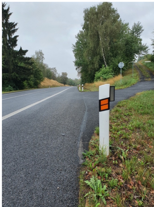
Obr. č. 20 Směrové sloupky. Zdroj: vlastní
