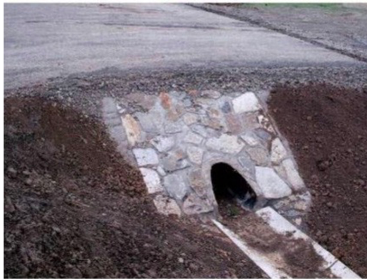
Obr. č. 11 Propustek se šikmým čelem Zdroj: Tomáš Mičunek
