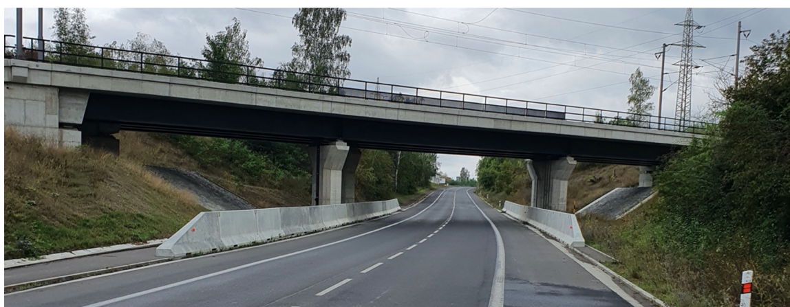
Obr. č. 13 Ukázka dostatečně chráněných mostních pilířů. Zdroj: vlastní
