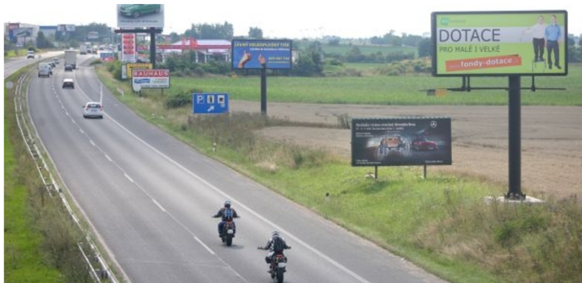
Obr. 15 Nestráněné nosné konstrukce reklam svodidlem Zdroj: Tyden.cz: Nebezpečné billboardy u silnic: odstranit jich půjde minimum [online]. [cit. 7.9. 2022]. Dostupné z: https://www.tyden.cz/rubriky/domaci/doprava/nebezpecne-billboardy-u-silnic-odstranit-jich-pujde-minimum_201722.html?showTab=nejctenejsi-24
