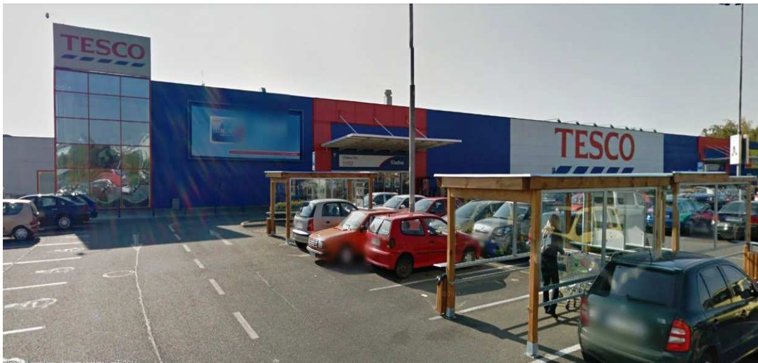
Obr.1: Fotografie řešeného objektu
