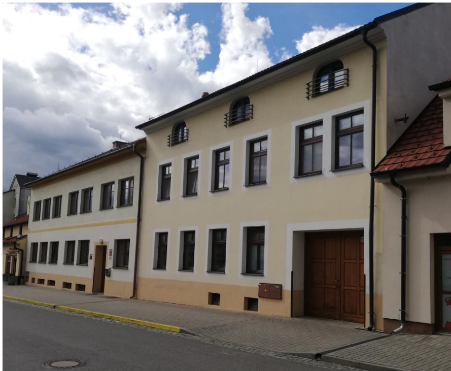
Obrázek 12: Děts.domov ve Strážnici, ulice B.Hrejsové, 2024. (Zdroj: vlastní zpracování)
