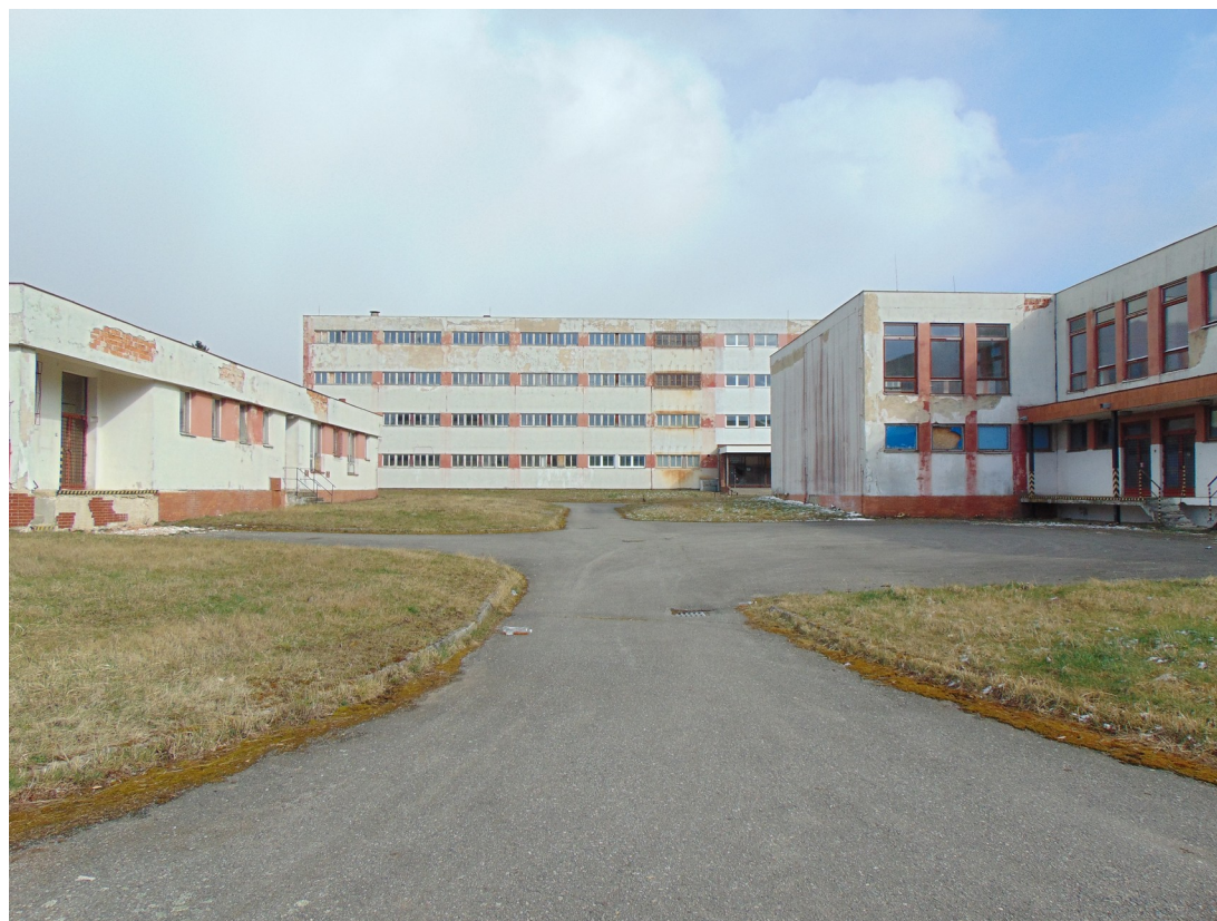
Příloha 7: Kasárna Pístop (vlastní, 2020)
