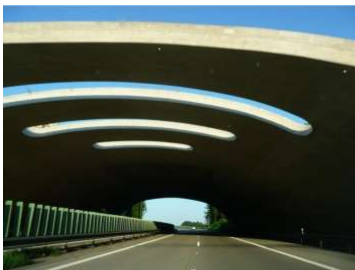
Obrázek 8: Nadchod na dálnici D11 mezi sjezdem EXIT 68 a 76 (Valenta 2011)
