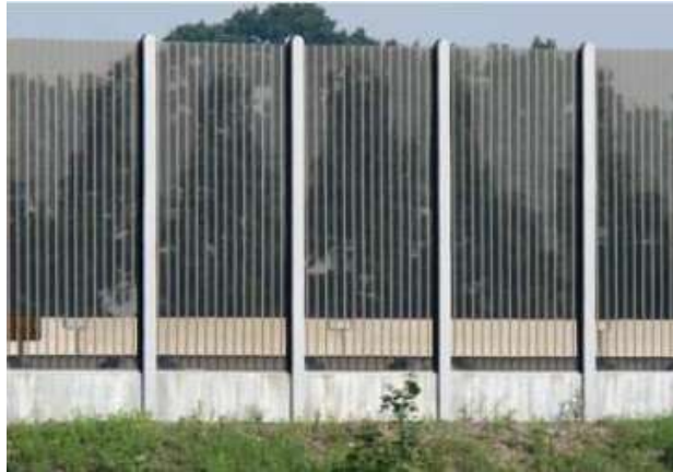
Obrázek 16: Průhledná protihluková stěna (Anděl et al. 2011)
