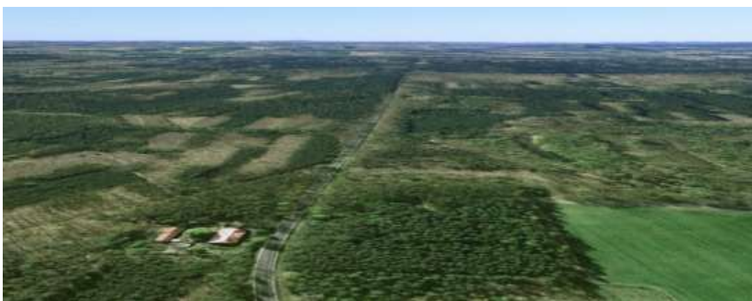
Obrázek 36: Pohled na silnici II. třídy č. 611, v úseku mezi obcemi Sadská a Mochov ( https://www.google.cz/maps/ , 2019)
