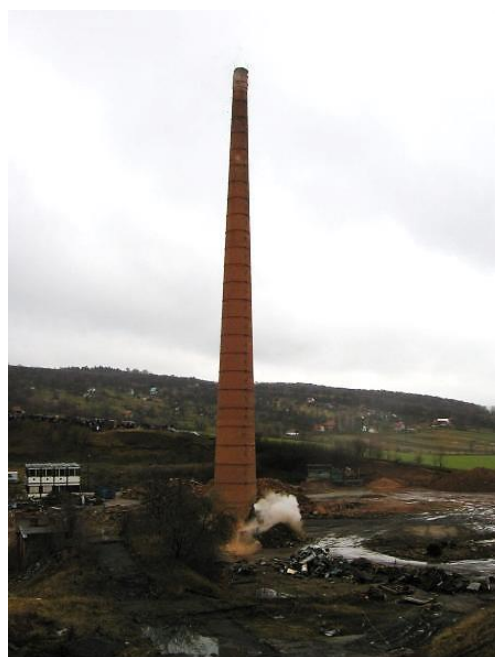
Obr. 56: Demolice komína cihelny v Havřicích
