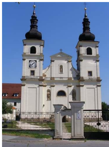
Obr. 63: Dominikánský kostel Uherský Brod
