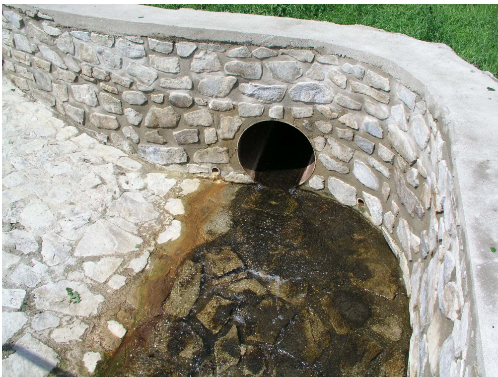
Obr. č. 19: Propustek u nové vodní nádrže (autor: Martin HEJMAN)
