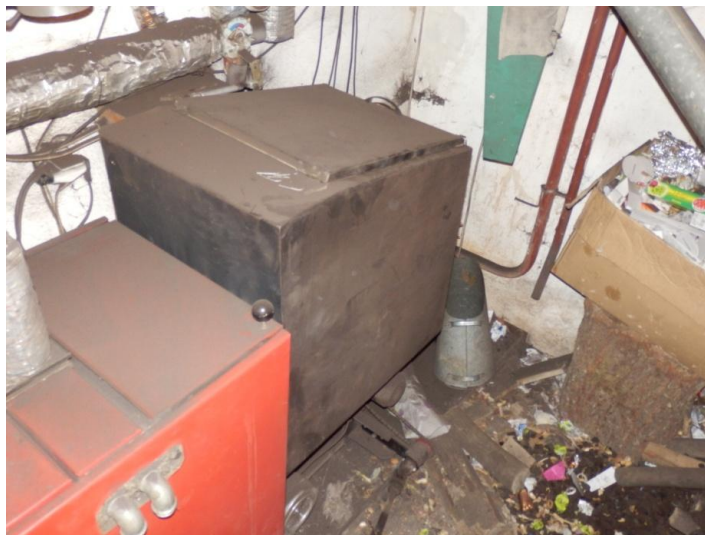
Obr. 15 – Zdroj tepla, kotel na tuhá paliva s automatickým přikládáním [zdroj: vlastní]
