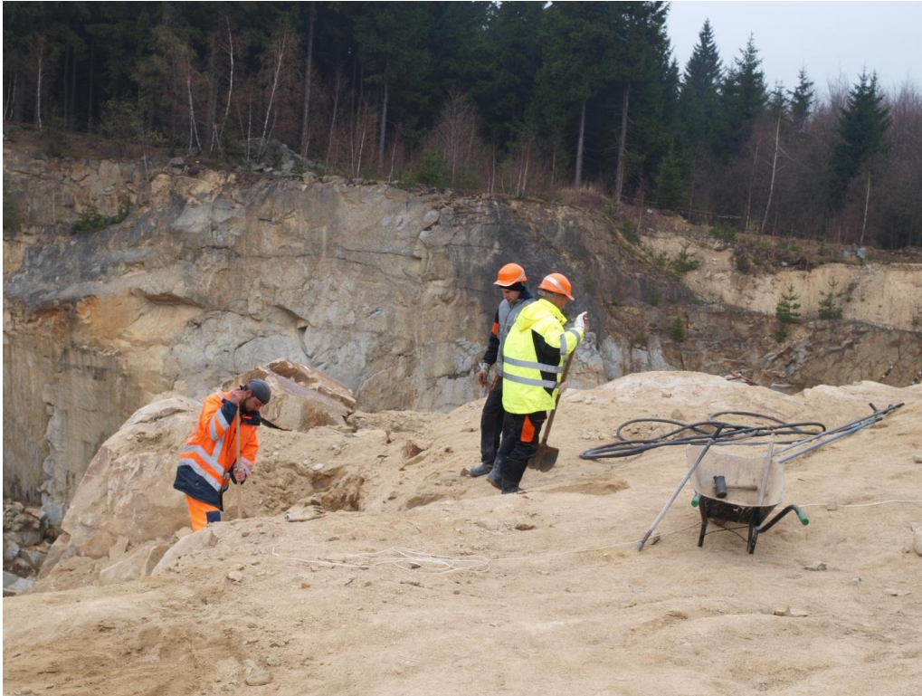
Příprava řízeného odstřelu
