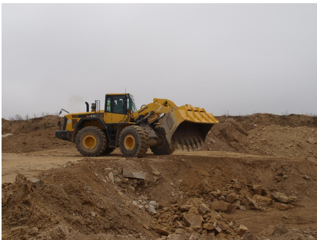
Vysokoobjemový čelní kolový nakladač při provádění skrývek
