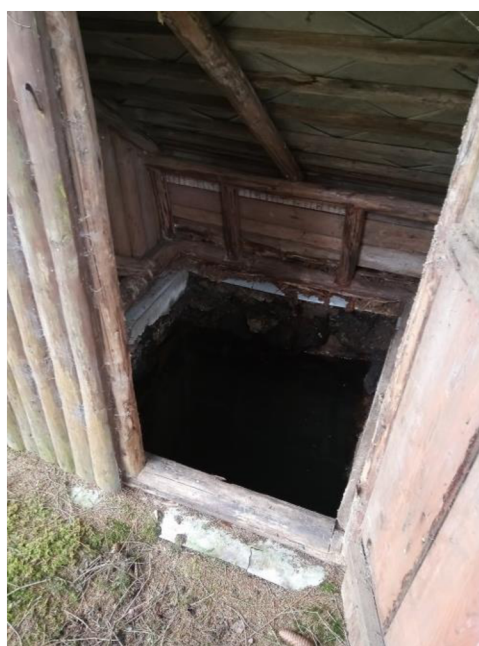
Dřevěná stavba kryjící pramen - vnitřek
